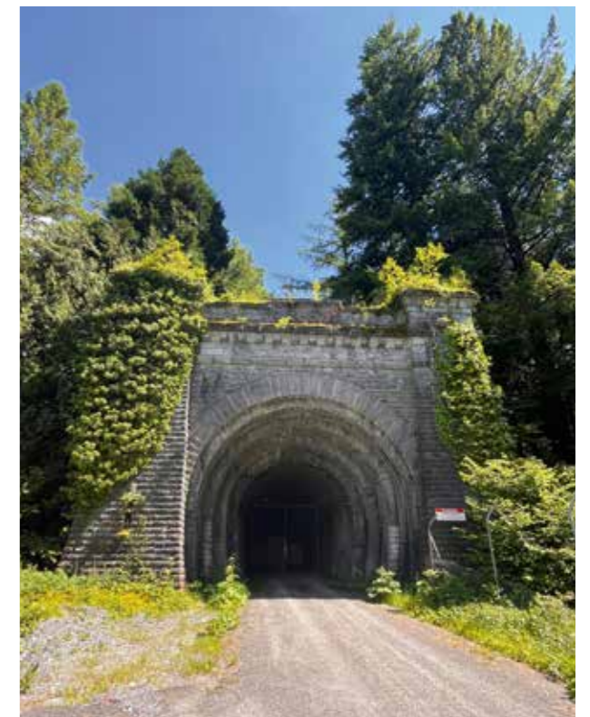
Les Forges d'Abel et l'entrée du tunnel du Somport. ©DR
