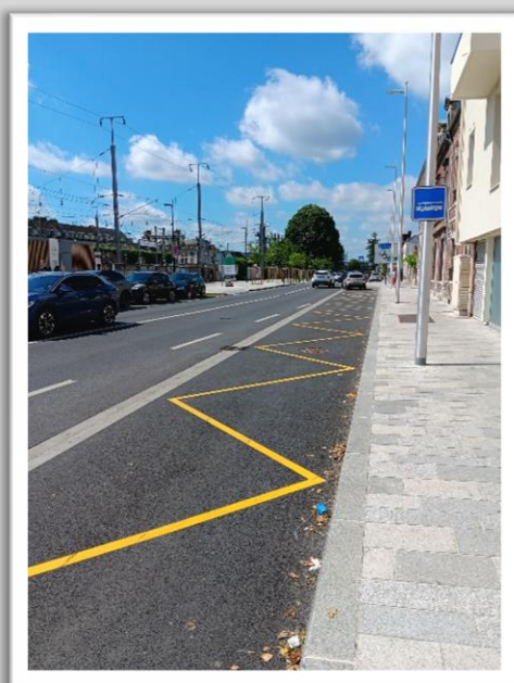
Arrêt SNCF vers Creil (quai A) situé 2 rue de Noyon (au niveau de la banque)
